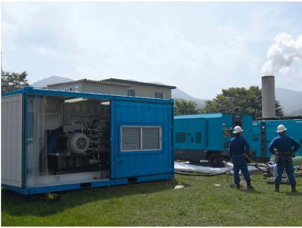
Im harten Outdoor-Einsatz ist der zuverlässige kontinuierliche Anlagenbetrieb ein absolutes Muß!
